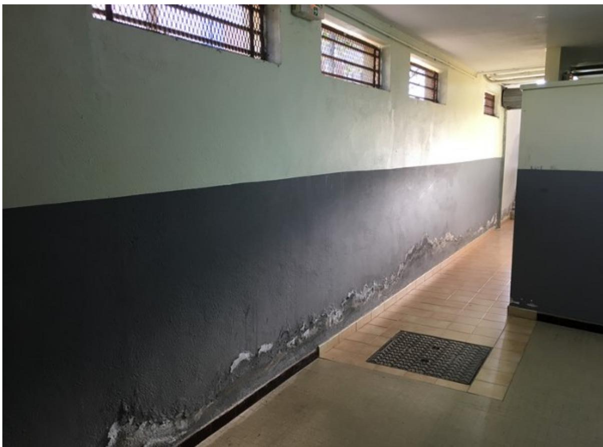
Infiltration car gouttières non nettoyées. Les gouttières sont accessibles par une trappe dont personne n'a la clé ! Ces gouttières devaient être nettoyées suite à une visite réalisée à l'école par les services.
