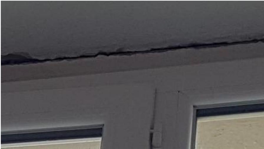
Fissure au dessus des baies vitrées. La fenêtre vibre.
